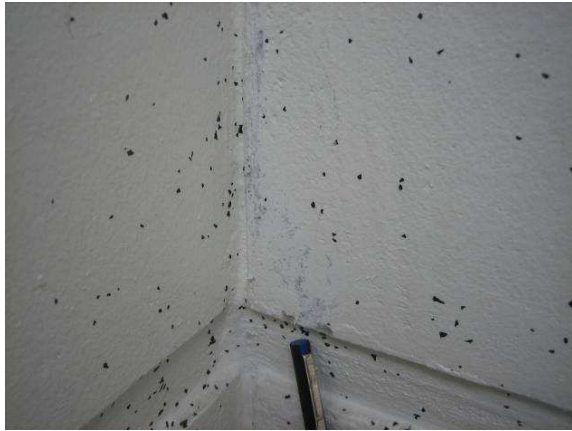
Foto 7: Prøve Bly 1 er udtaget af vægmaling ved repos ml. 6. og 7. etage i opgang 27
