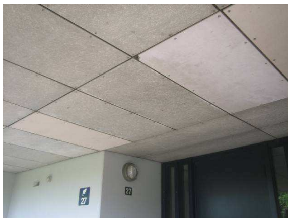
Foto 11: Forskellige loftsplader ved søjlegang under bygningens sydside
