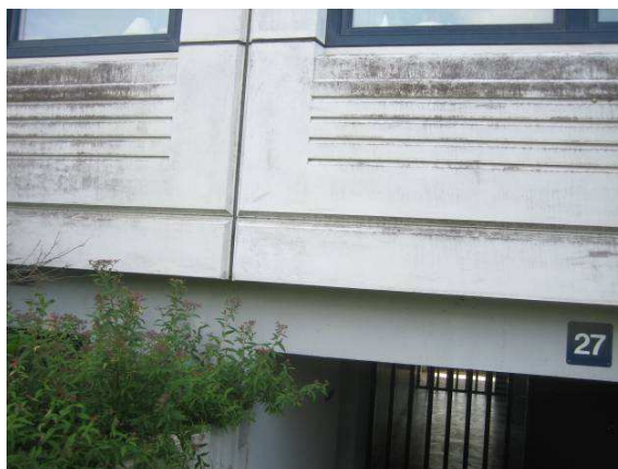
Foto 14: Facadefuger mellem facadeelementer på nordsiden af bygningen
