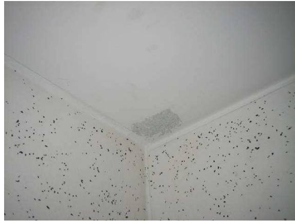
Foto 8: Prøve Bly 2 er udtaget af loftsmaling ved 7. etage i opgang 27
