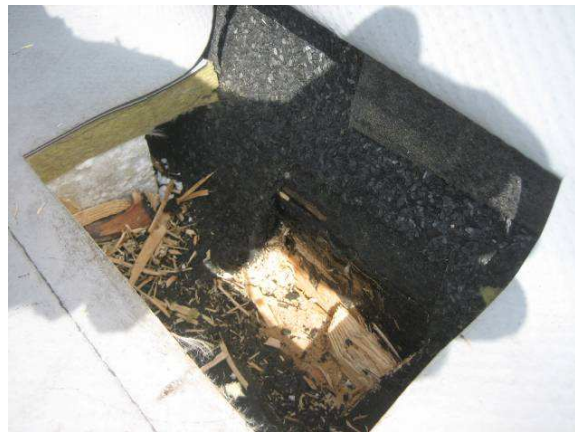
Foto 22: Øverste udgøres taget af en gummimembran. Herunder findes ca. 25 mm isolering af glasuld, underlagt af ca. 50 mm flamingo, som er lagt direkte på paptag. Under paptaget findes en trækonstruktion, som ikke blev gennembrudt ved undersøgelsen.
