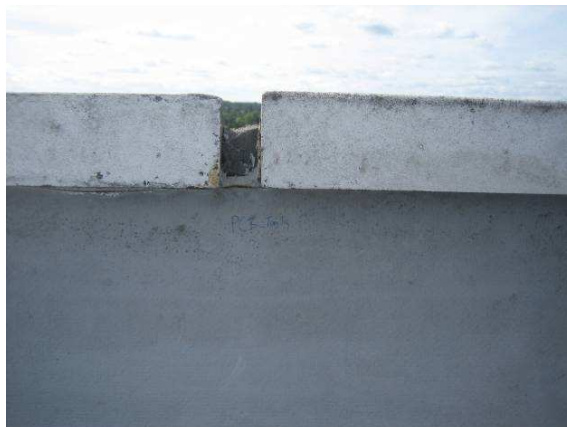
Foto 2: Prøve PCB 1 er udtaget som samleprøve af 3 delprøver, her delprøve PCB1a
