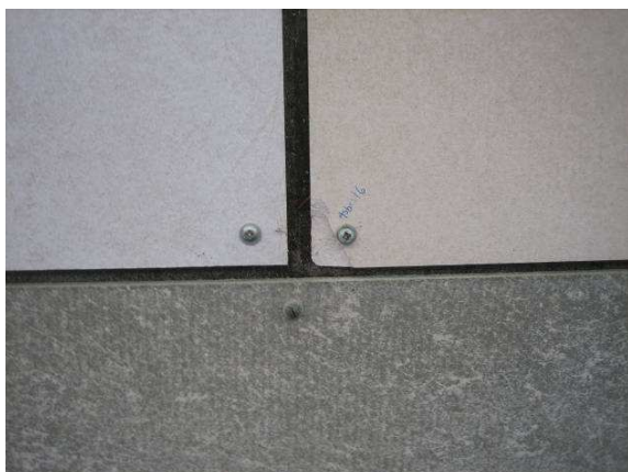
Foto 13: Prøve Asbest 6 af meget lysegrå loftsplade fra søjlegangen under bygning ved opgang 27
