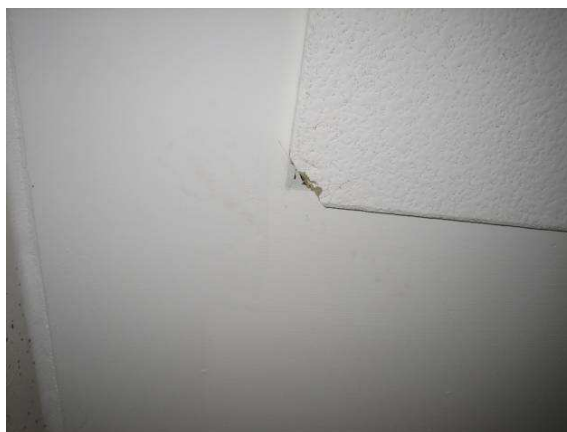
Foto 6: Prøve Asbest 2 er udtaget fra loftsplade i opgang ved lejl. 27,7.tv
